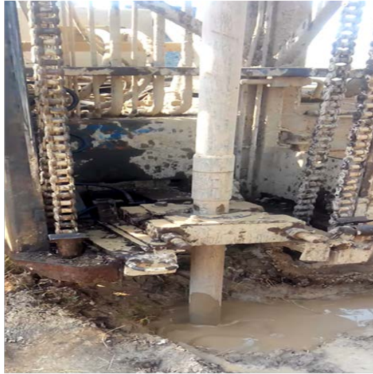
Figura 11 Instalația de foraj
